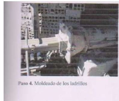
Figura 25: Moldeado del ladrillo
