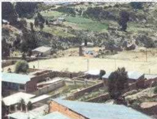
ANEXO 3 FOTO 2 CANCHA EN MAL ESTADO DE LA ZONA TEJADA ALPACOMA BAJO, EL ALTO.
