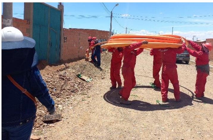
Figura 24: Tendido de red secundaria
