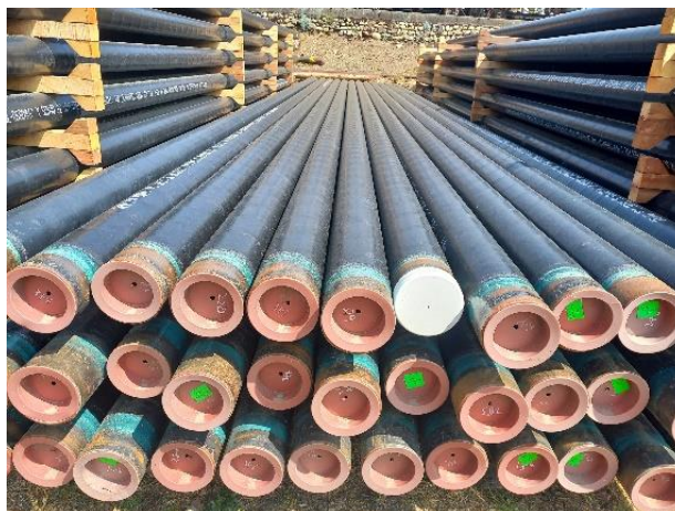
Figura 22: Tuberías de red primaria SCH 40 de 6" DN.
