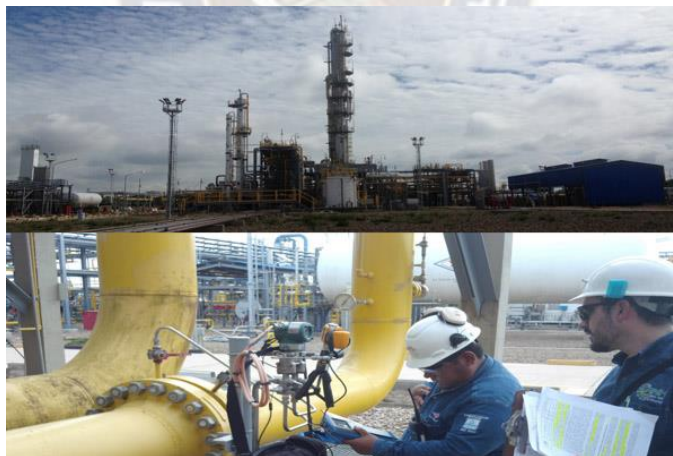
Figura 14: La Planta de Separación de Líquidos de Río Grande
