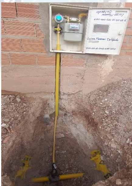
Figura 25: Derivación de red secundaria a la acometida
