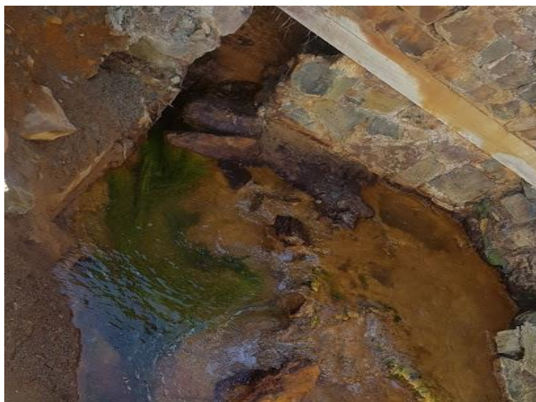
Figura 25 Bocamina de Milluni Fuente propia
