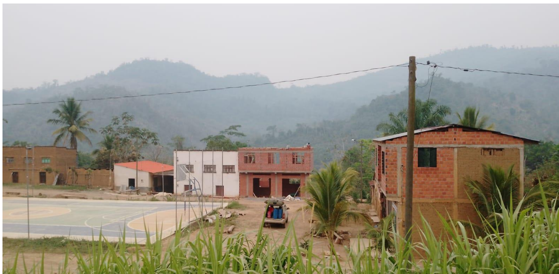
Foto 3 Ubicación Plaza Principal Villa Elevación
