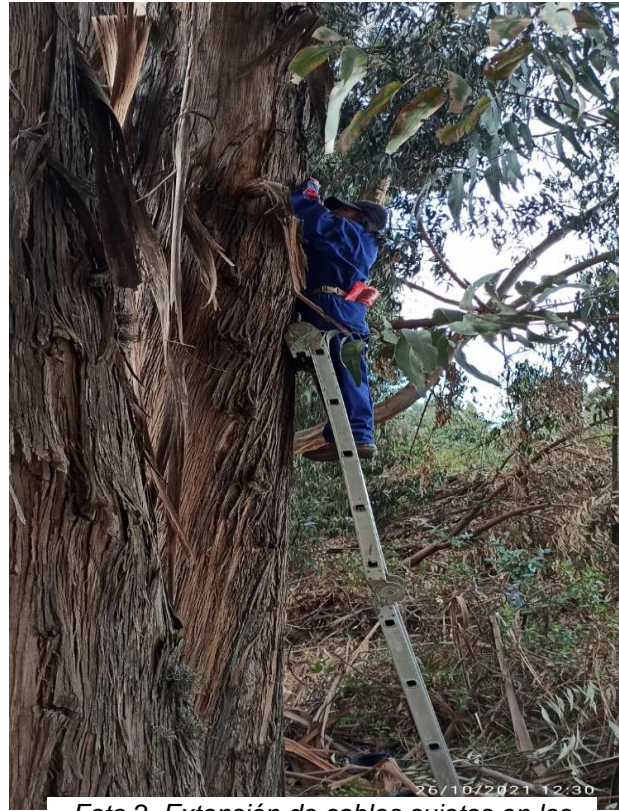
Foto 2. Extensión de cables sujetos en los árboles
