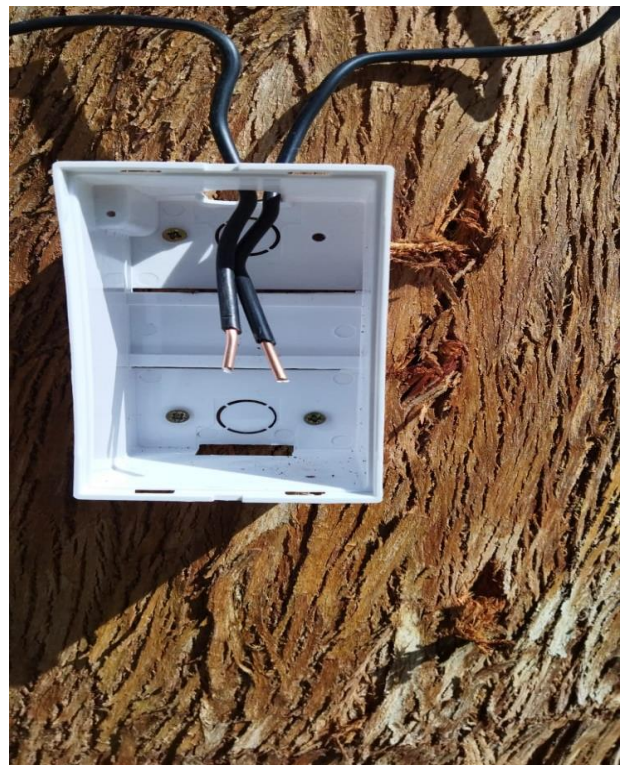
Foto 7. Colocado de protector de térmico
