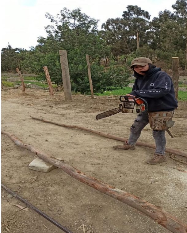
Foto 4. Dimensionado y cortado de postes
