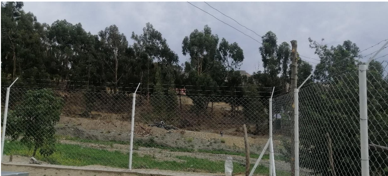
Foto 3. Colocado del poste en la parte externa del módulo
