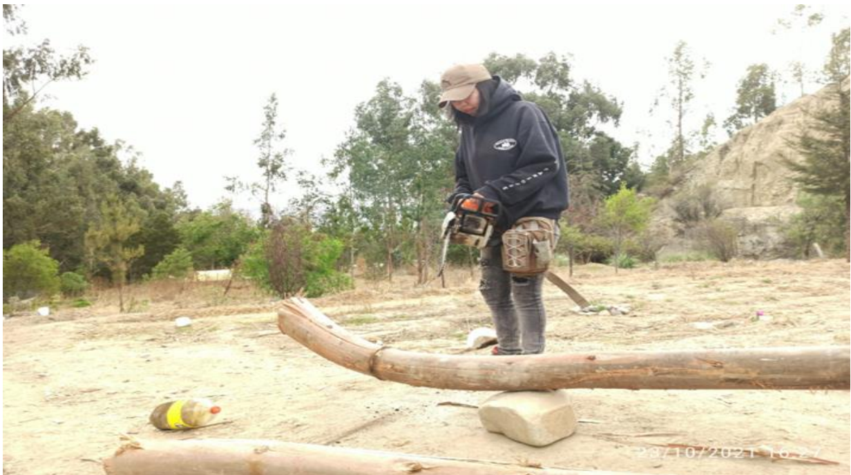
Foto 10. Cortado de postes con la motosierra
