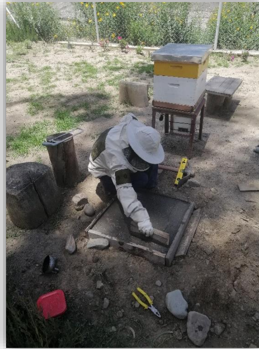
Figura 22. Planchado del cemento
