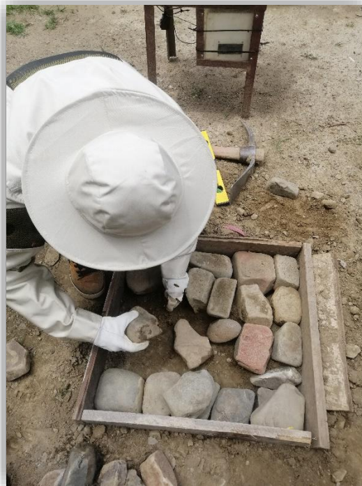
Figura 21. Armado con piedras del hormigón ciclópeo
