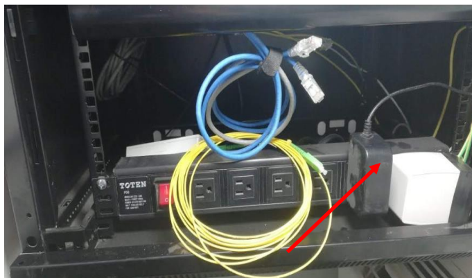
Figura 25: Fotografía del adaptador de la cámara IP en el Gabinete Fuente: Fotografía propia
