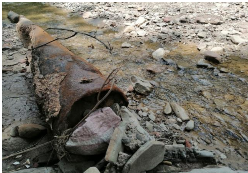
En algunas zonas de la vertiente se puede observar tuberías de gas en desuso
