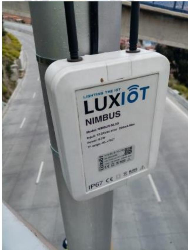
Figura 94 Montaje de equipo Nimbus en poste de alumbrado público
