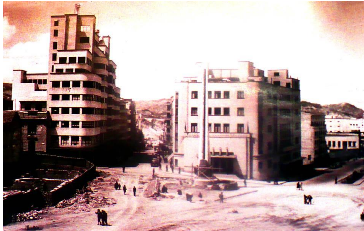
Imagen 3: Área de Construcción de la Escuela de Ingeniería
