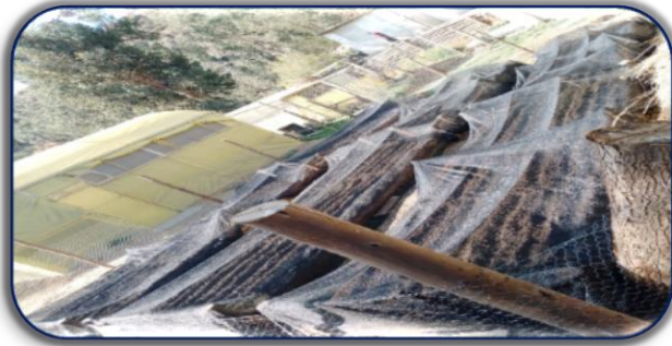
Figura 8. Colocado de malla semisombra
