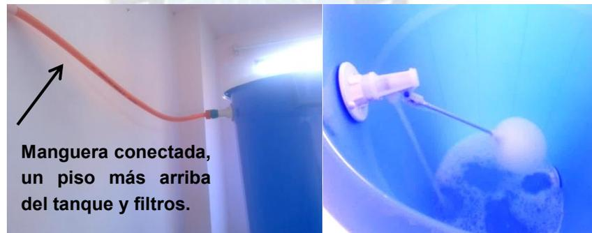
Luego el agua clarificada del tanque de almacenamiento, pasara hacia el filtro de grava regulando las llaves de paso, para que el proceso sea lento según (Figura 6.24 y 6.25) y filtre solo agua tratada del filtro de arena, (Figura 6.25).
