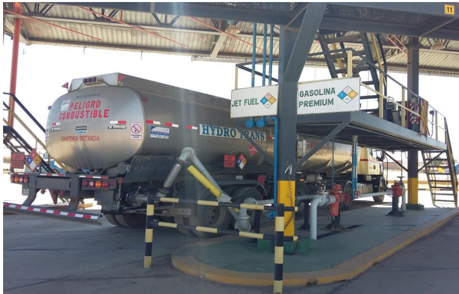
Ilustración 1. Área de carga y descarga de líquidos
