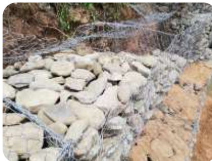
5 CONSTRUCCION DE GAVIONES DEFENSIVOS
