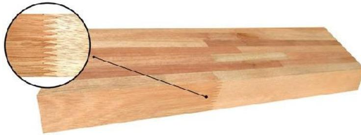
Figura 2.2 Junta Finger entre dos piezas, longitudinalmente
