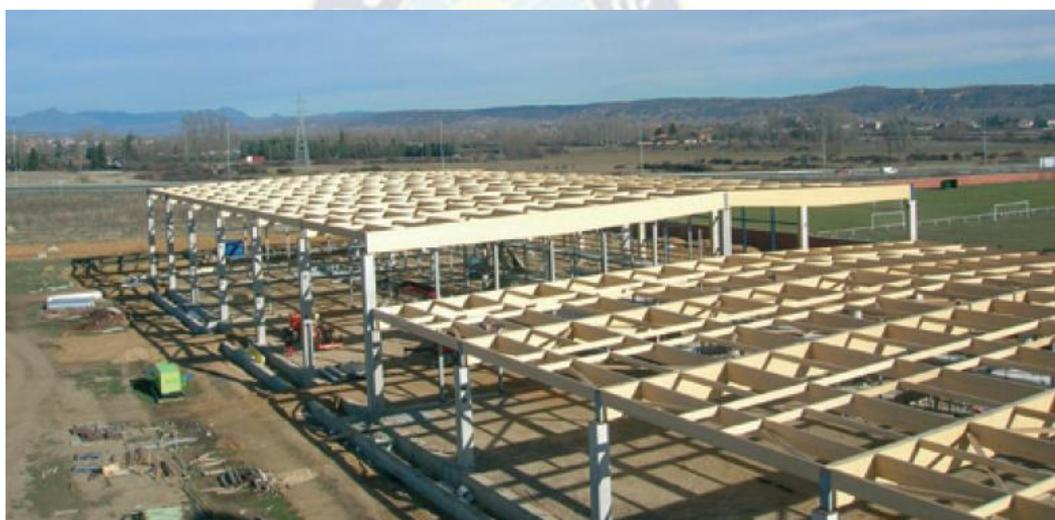
Figura 2.1 Estructura de madera laminada para una nave industrial
