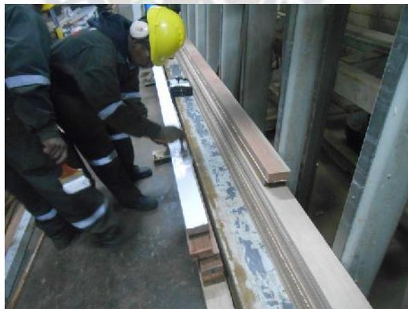
Foto 4.21 Aplicación del pegamento de forma manual.
