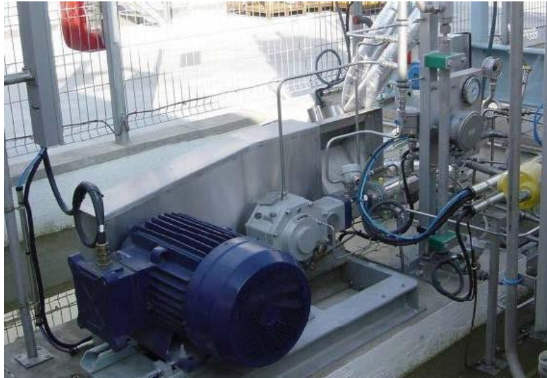
Figura 4 Bomba criogénica de pistones
