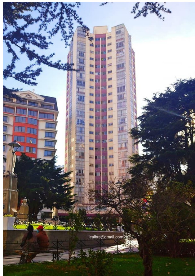
Fotografía 14: Edificio Fernando V, Fuente: José Enrique Alba
