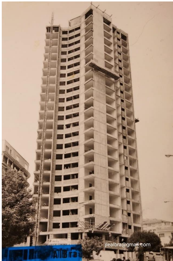
Fotografía 13: Edificio Fernando V en construcción, década 1970 Fuente: José Enrique Alba
