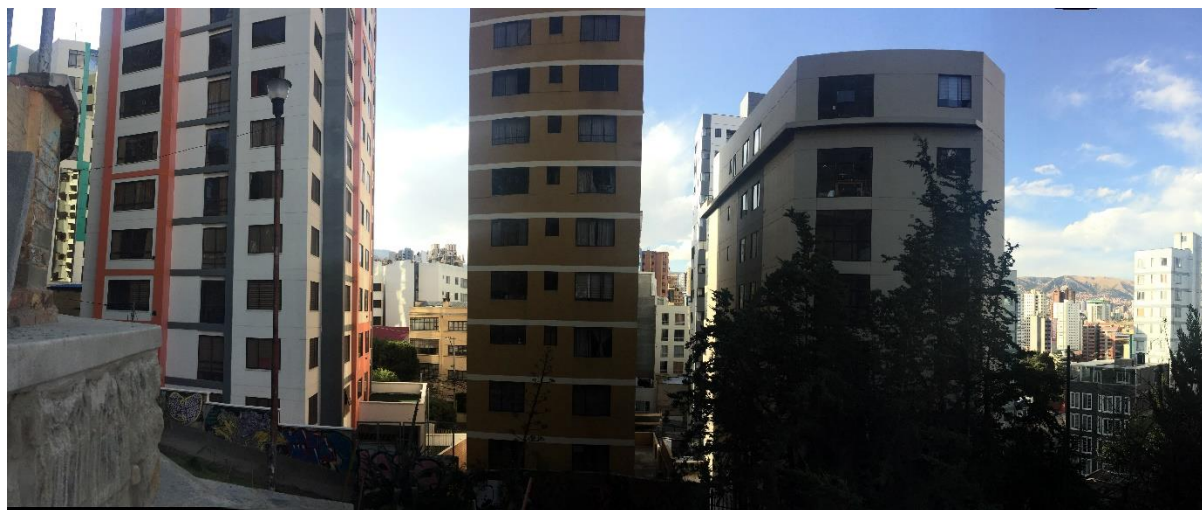
Fotografía 20: Edificios lado norte PMM Fuente: Elaboración propia
