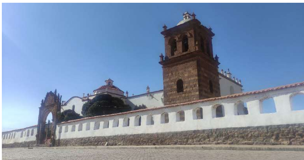
(Fig. 3) Iglesia Jesús de Machaca - Puerta principal Fuente: Fotografía propia tomada el 20 de Mayo de 2021.
