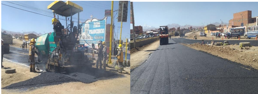
Fotografía N° 16 Carpeta Asfáltica
