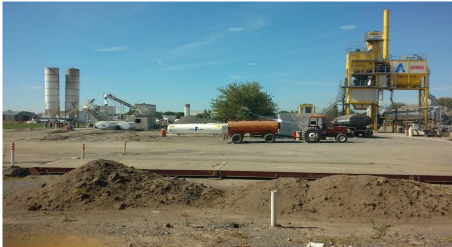
Fotografía N a 7 La Planta de Asfalto
