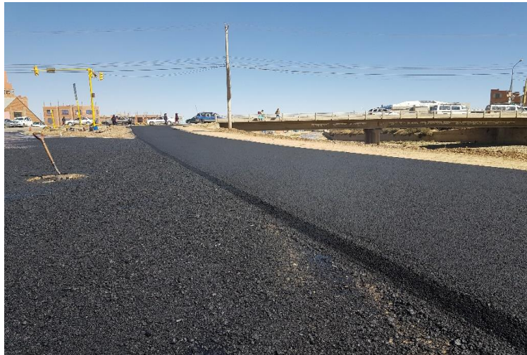
Anexo 8 Carpeta Asfaltado
