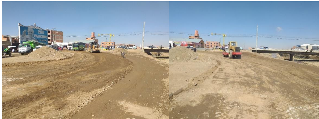
Fotografía N° 13 Conformación de Capa Sub Base
