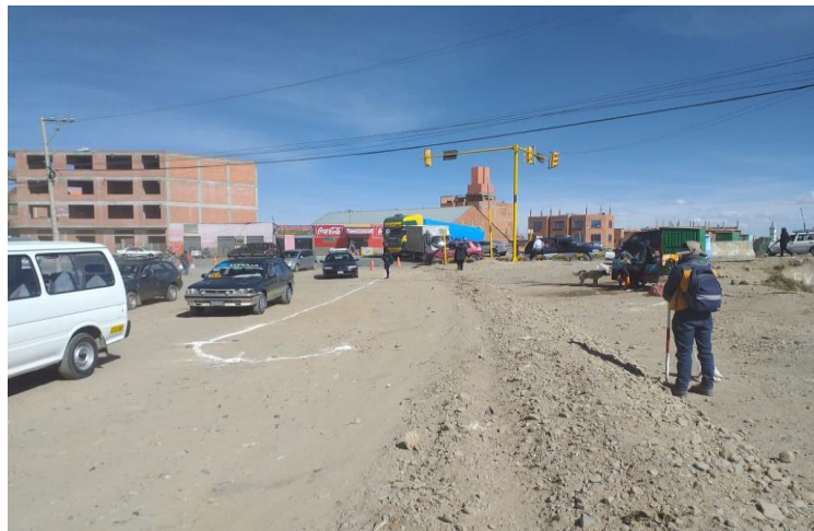
Fotografía N° 8 Trazado y Replanteo
