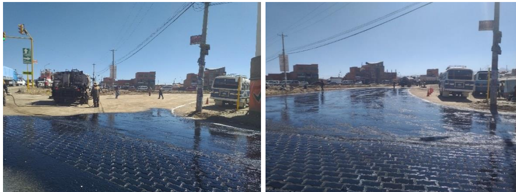
Fotografía N o 15 Imprimación Bituminosa
