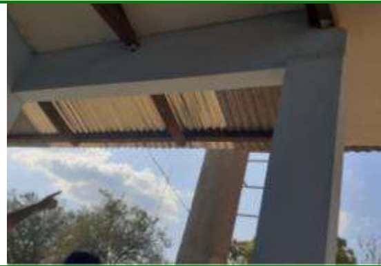
Foto N° 16 y 17 Hojas de calamina cambiada
