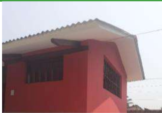
Foto N° 5 10 Revoque cielo raso aleros
