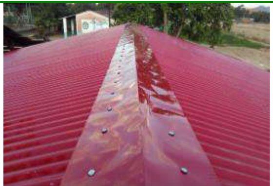
Foto N° 19 y 20 Cubierta de calamina n. 28 + estruc. De madera Cumbreira de calamina plana n°28
