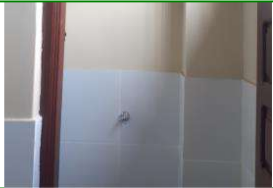
Foto N° 24 Cambio de marcos
