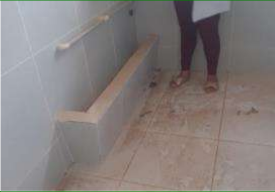
Foto N° 11 21 Urinario de cemento
