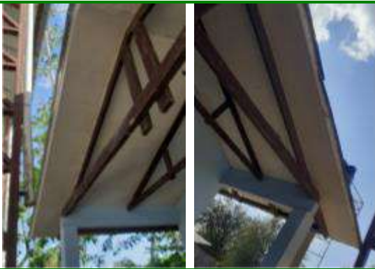
Foto N° 15 Cielo raso acabada
