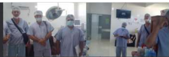
INSPECCION DE AREA DE QUIROFANO Y SALA DE PARTO DEFICIENCIAS DE CIELO RASO E INSTALACIONES ELECTRICAS HOSPITAL SAN BORJA
