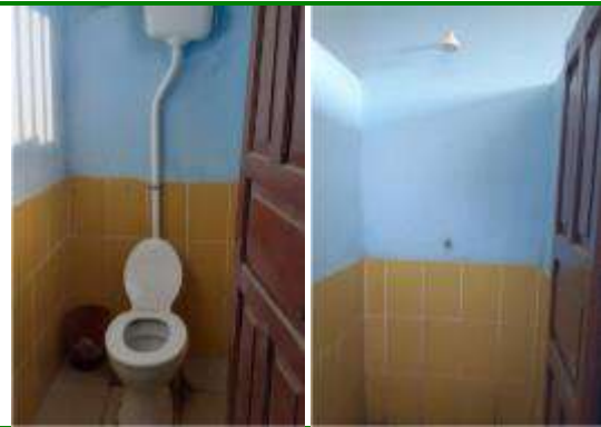
Foto N° 10 Inodoros acondicionados y duchas
