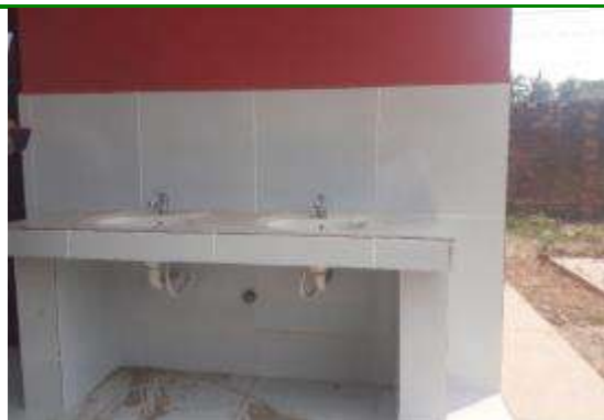
Foto N° 5 11 Revoque exterior de cemento 20 Prov. y coloc. de lavamanos c/pedestal 25 Prov. y coloc. de tubo desague pvc de 2"
