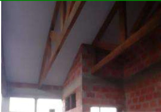
Foto N° 9 y 10 Cielo falso pvc viga vista
