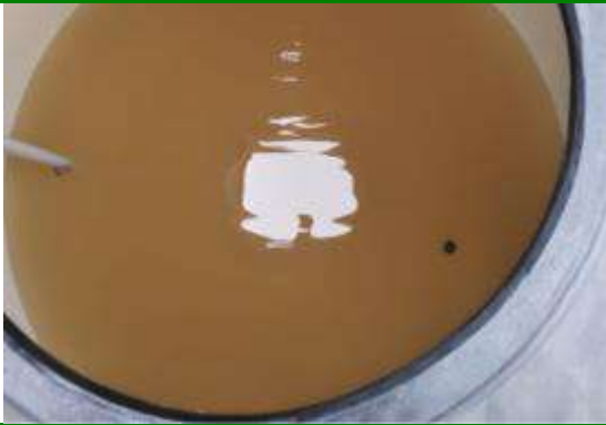
Foto N° 7 Agua en tanque bajo.
