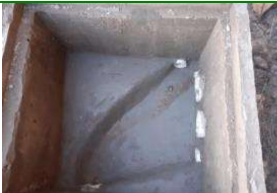
Foto N° 17 y 18 Cámara de inspección (0.60*0.60*0.75)
