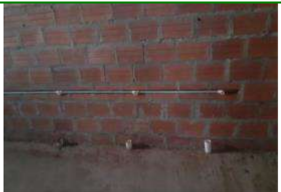
Foto N° 15 y 16 Instalación de agua potable.
