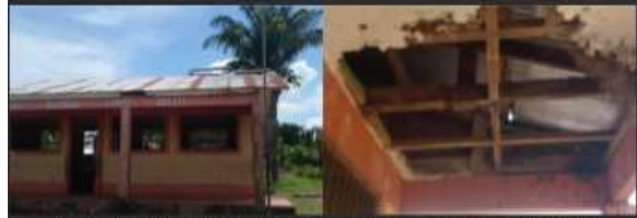
RELEVAMIENTO DE UNIDAD EDUCATIVA CAMPO BELLO PARA SU RESPECTIVO REFACCION
