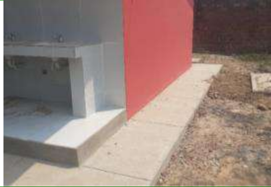
Foto N° 4 6 Pretel de ladrillo tubular 8 Piso de cemento frotachado
