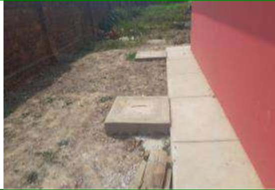
Foto N° 12 22 Camaras de inspeccion 0.60*0.60
