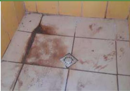
Foto N° 11 Rejilla de piso en las duchas.
