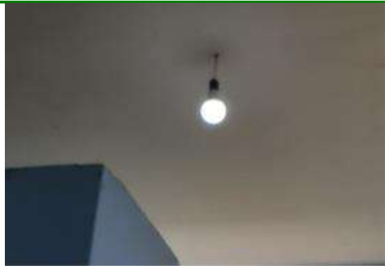
Foto N° 12 Punto de Iluminación refaccionada.
