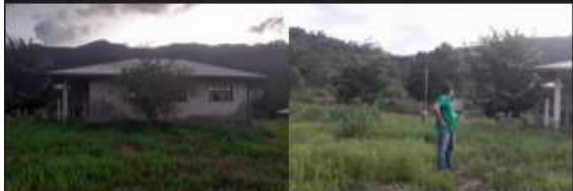
VIAJE A RELEVAMIENTO PARA UNA NUEVA CONSTRUCCION DE CENTRO DE SALUD QUIQUIBEY
