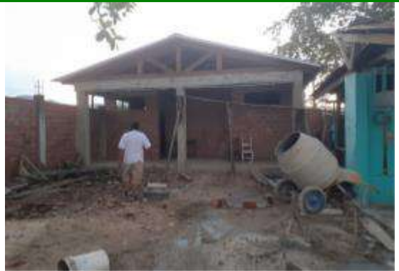
Foto N° 11 y 12 Columnas de h° a°
