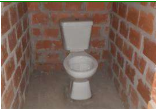
Foto N° 13 y 14 Prov y coloc. De inodoro tanque bajo
