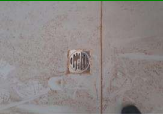
Foto N° 13 24 Rejilla de piso
