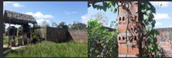
RELEVAMIENTO DE DATOS PARA LA CONSTRUCCION DE AULAS UNIDAD EDUCATIVA ARNULO NUÑEZ SAN BORJA
