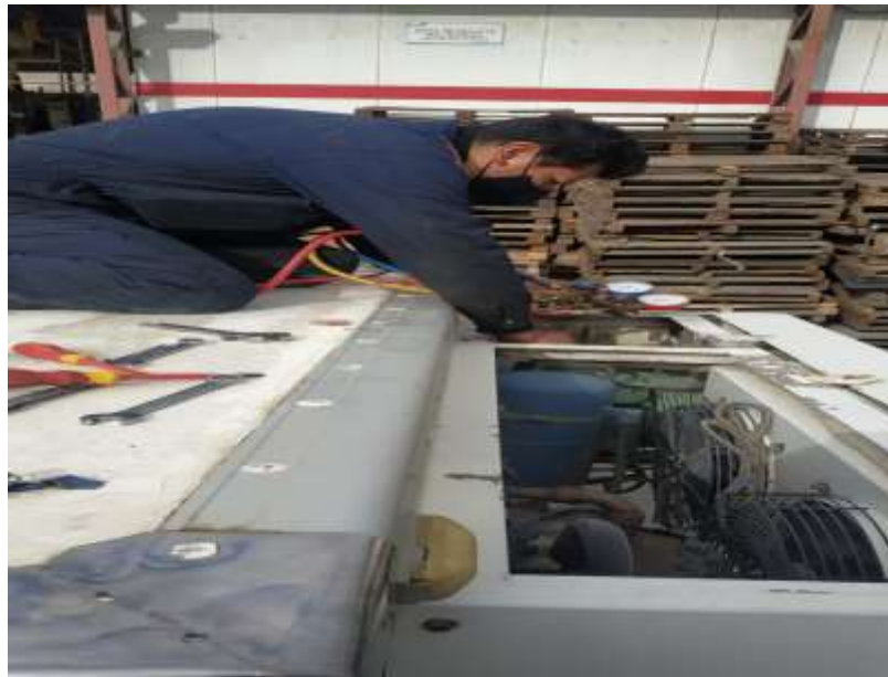
Fotografía 21. Instalación de manómetros, inspección de microfugas. Fuente. Elaboración propia
