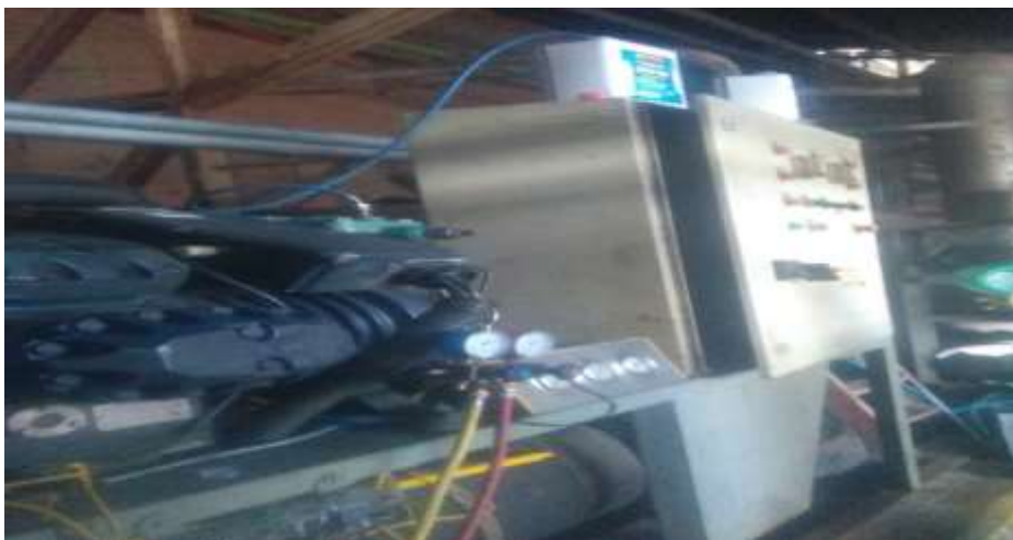
Fotografía 11. Carga de aceite al compresor Fuente. Elaboración propia
