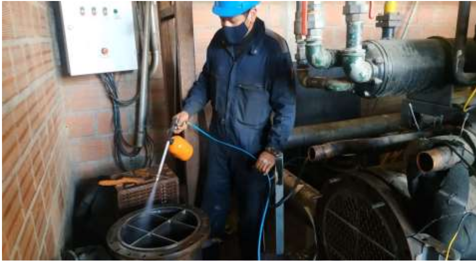
Fotografía 9. Limpieza de evaporador Fuente. Elaboración propia
