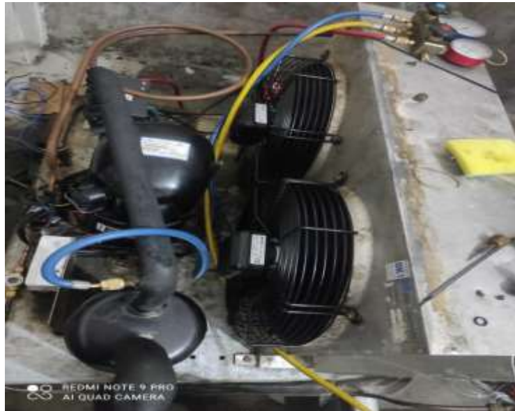
Fotografía 17. Carga de refrigerante a enfriador tipo tanque Fuente. Elaboración propia
