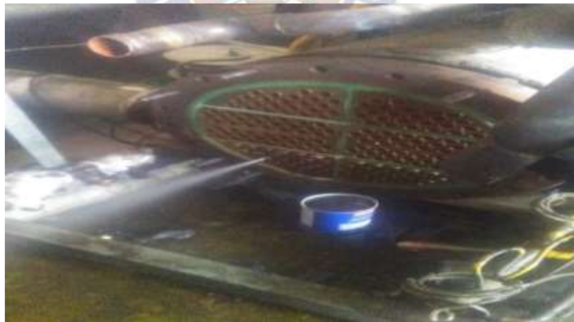
Fotografía 10. Limpieza de tubo en el evaporador Fuente. Elaboración propia
