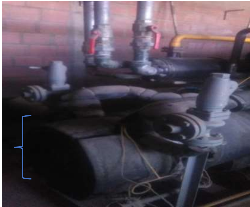
Fotografía 5. Evaporador de tipo casco y tubo Fuente. Elaboración propia
