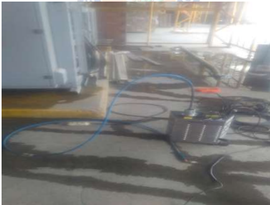
Anexo 4. Máquina automática para limpieza de tubos
