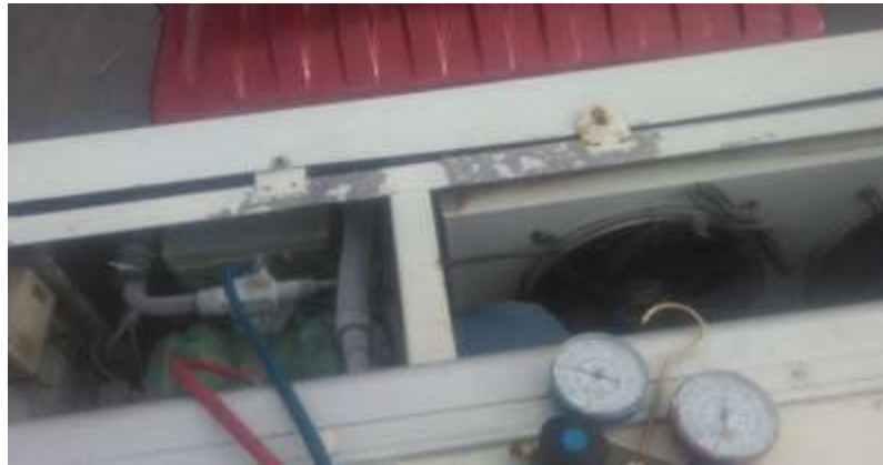
Fotografía 20. Lectura de presiones en reefer Fuente. Elaboración propia
