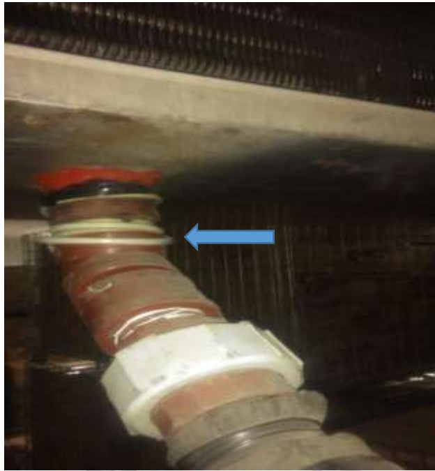
Fotografía 13. Disposición del Cable calefactor Fuente. Elaboración propia
