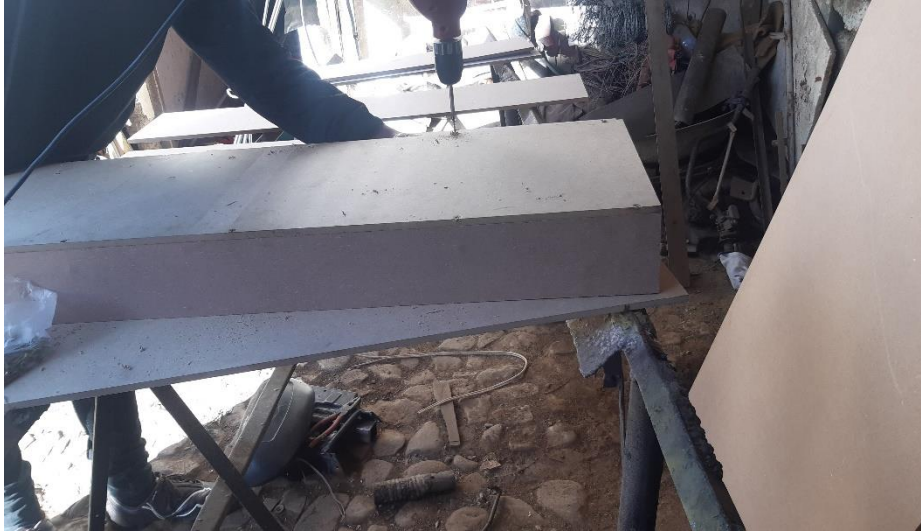
Figura N° 36. armada de la estructura base
