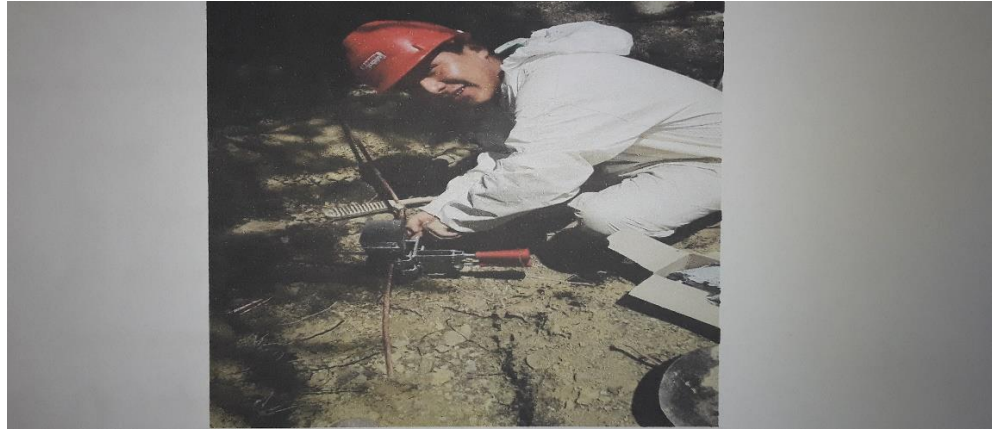
Figura 83 Conexión por soldadura HEXO TERMICA
