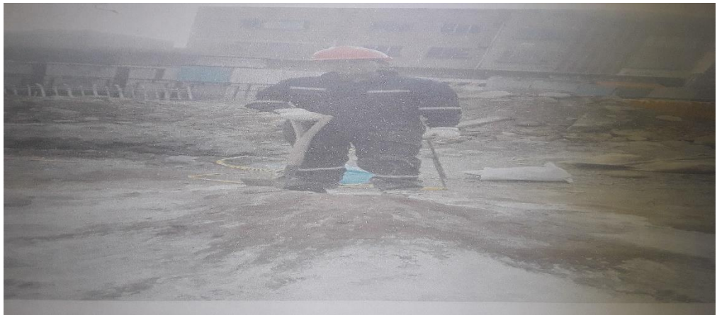
Figura 82 Mescla de la bentonita, geo gel con tierra tratada
