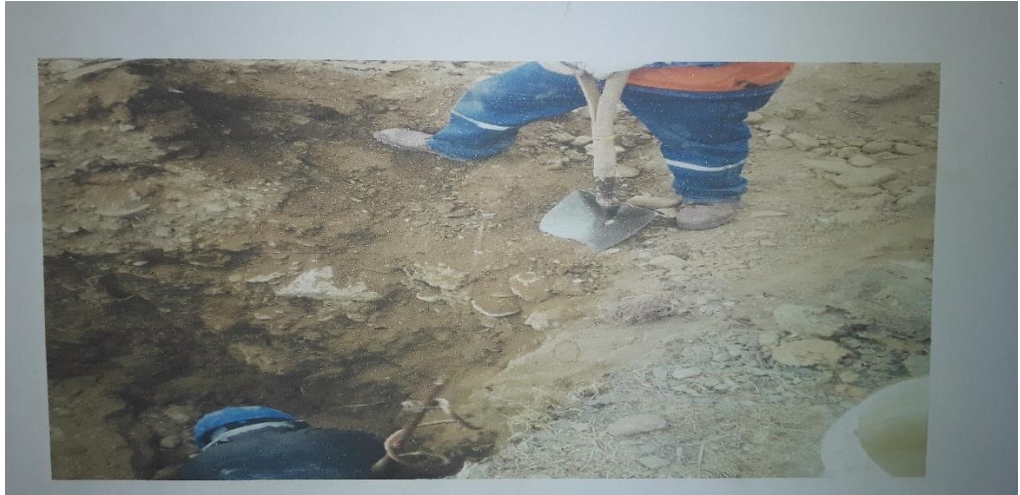
Figura 81 Acoplamiento de la jabalina a las perforaciones
