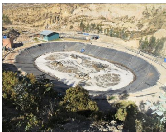
Figura 15: Relleno sanitario de Alpacoma
