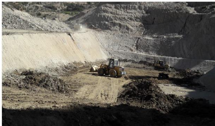
Figura 8: Excavación de fosas
