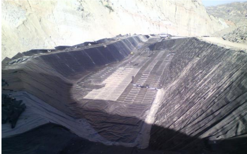
Figura 10: Impermeabilización
