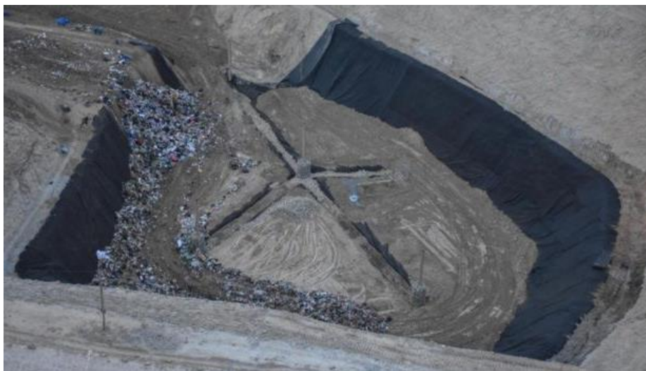
Figura 2: Relleno sanitario de Sak'a Churu
