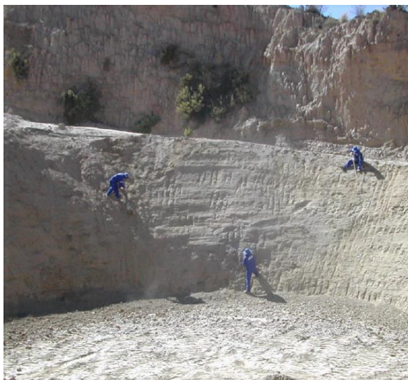
Figura 9: Peinado de taludes
