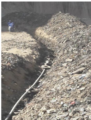
Figura 11: Instalación de drenajes
