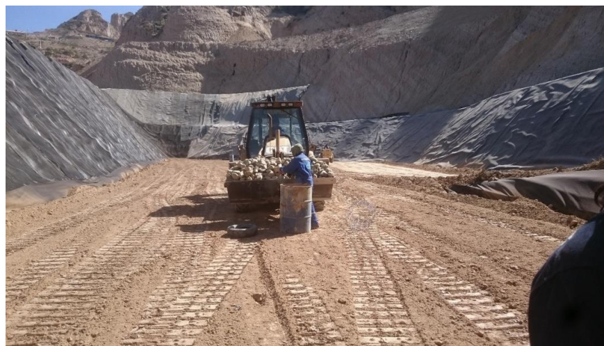
Figura 14: Estructuras de evacuación de gas
