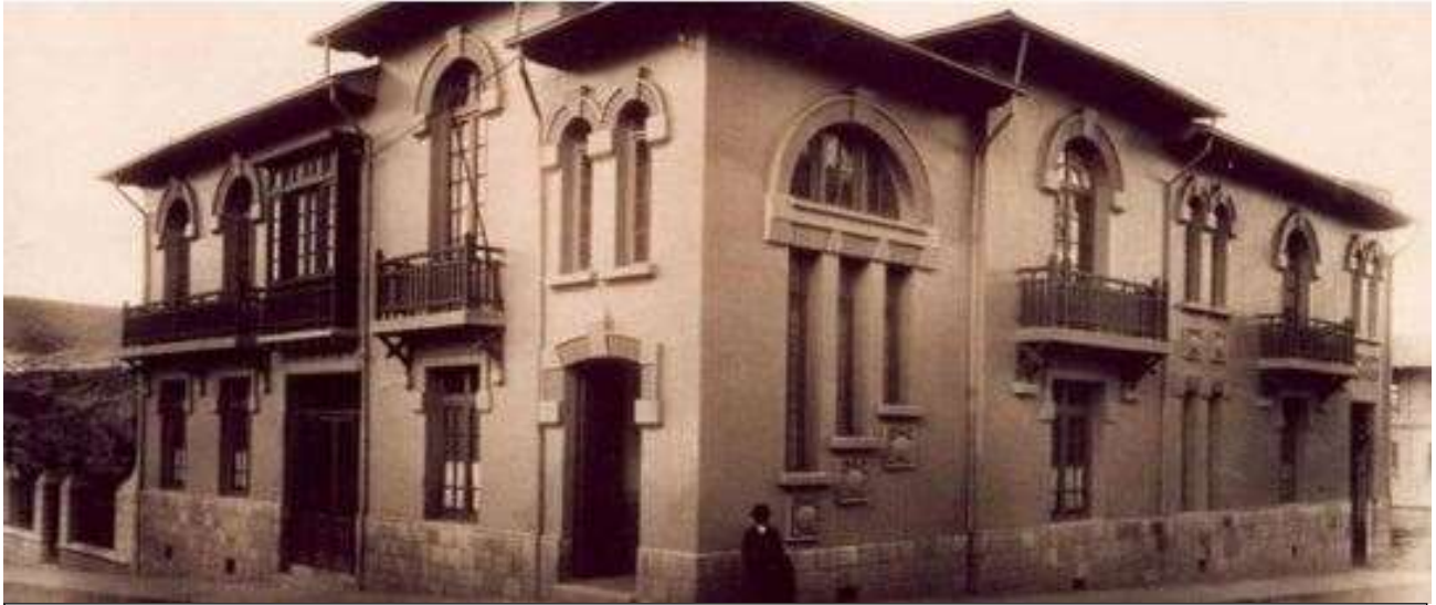
Fig15. Fotografía de antaño del Conservatorio Plurinacional de Música. Fuente: fig. http://www.coplumu.edu.bo/history.php
