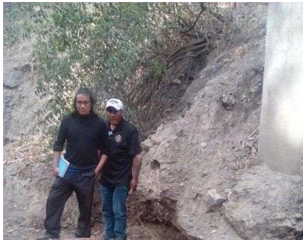
Figura 14. Toma de punto con GPS de fundación de paso de quebrada
