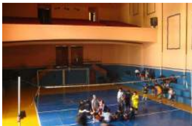
Estado actual del interior del Ex cine Universo. Fuente: (Palacios & Cazas, 2014)
