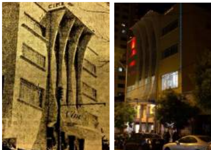
Fachada frontal del Cine Teatro Municipal 6 de Agosto en sus inicios y en la actualidad Fuente: (La Paz Culturas, 2020)
