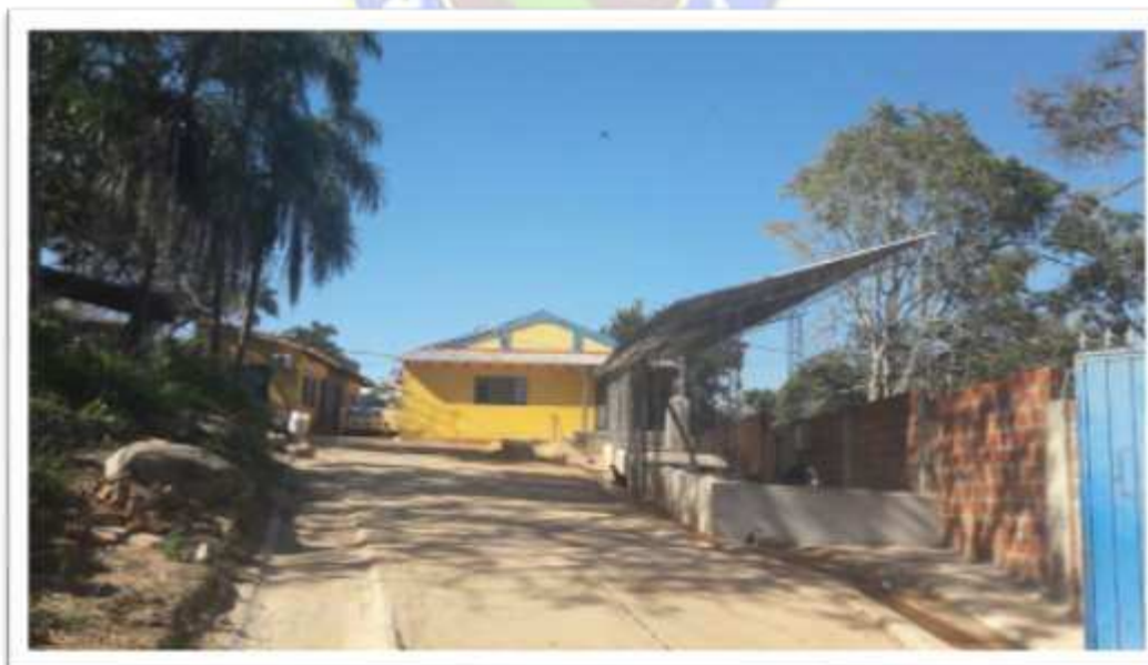
FIGURA N° 3: Vista frontal de la Planta Elaboradora de Quesos "San Mateo"
