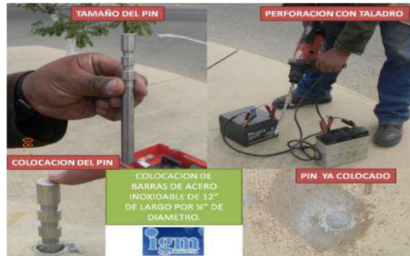
Figura 52 – Monumentación de Varillas de acero “PINES”
