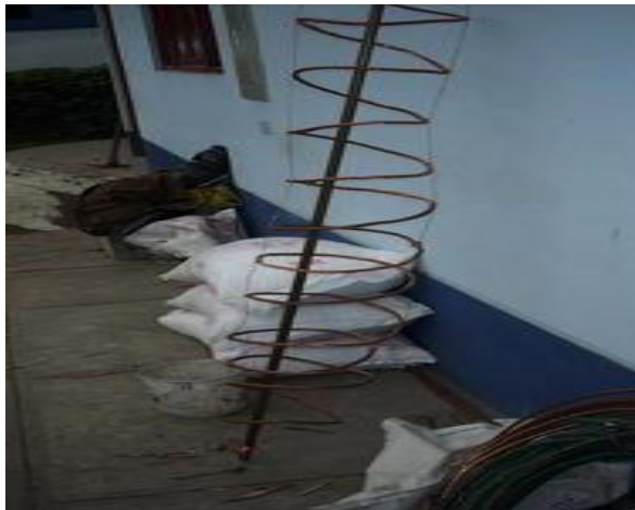
Fig46. Espiral de cable desnudo alrededor del electrodo.
