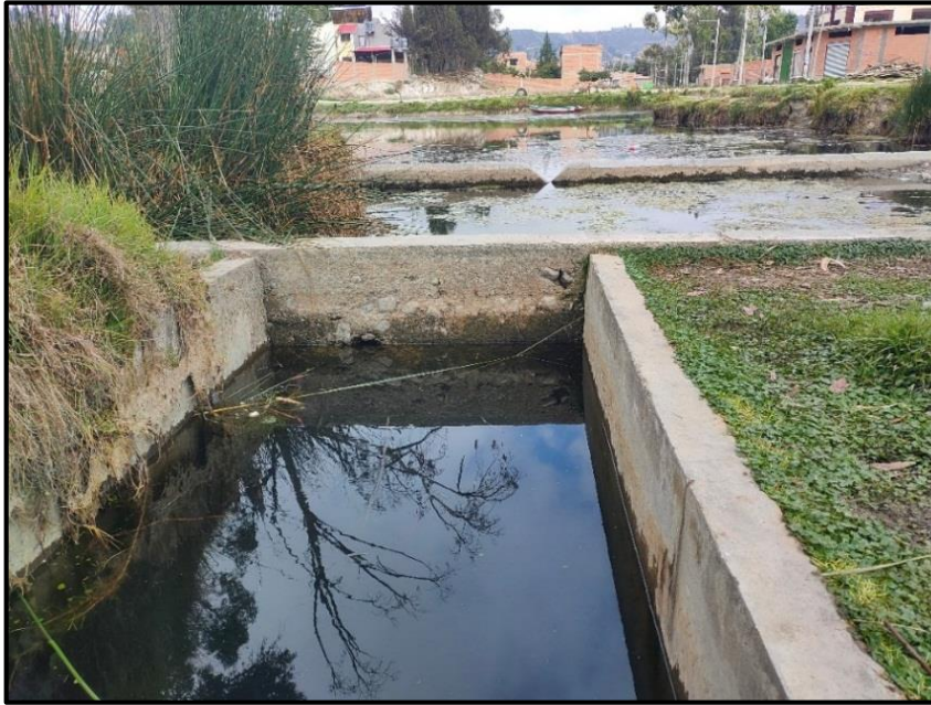
Figura 8. Presa laguna Charani.
