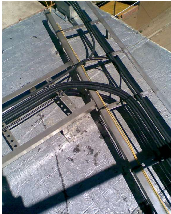
Figura 2-25: Tendido de cables en escalerillas
