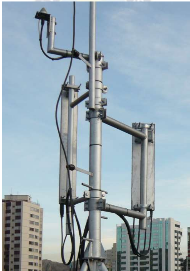
Figura 2-22: Montaje de las Antenas RF
