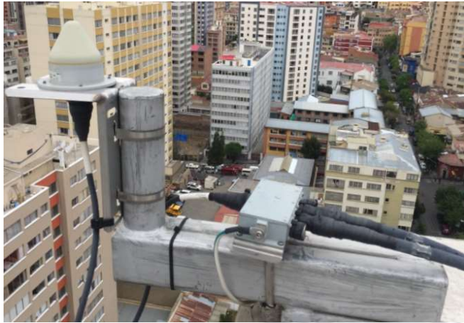
Figura 2-23: Montaje de antena GPS y Splitter con 2 derivaciones
