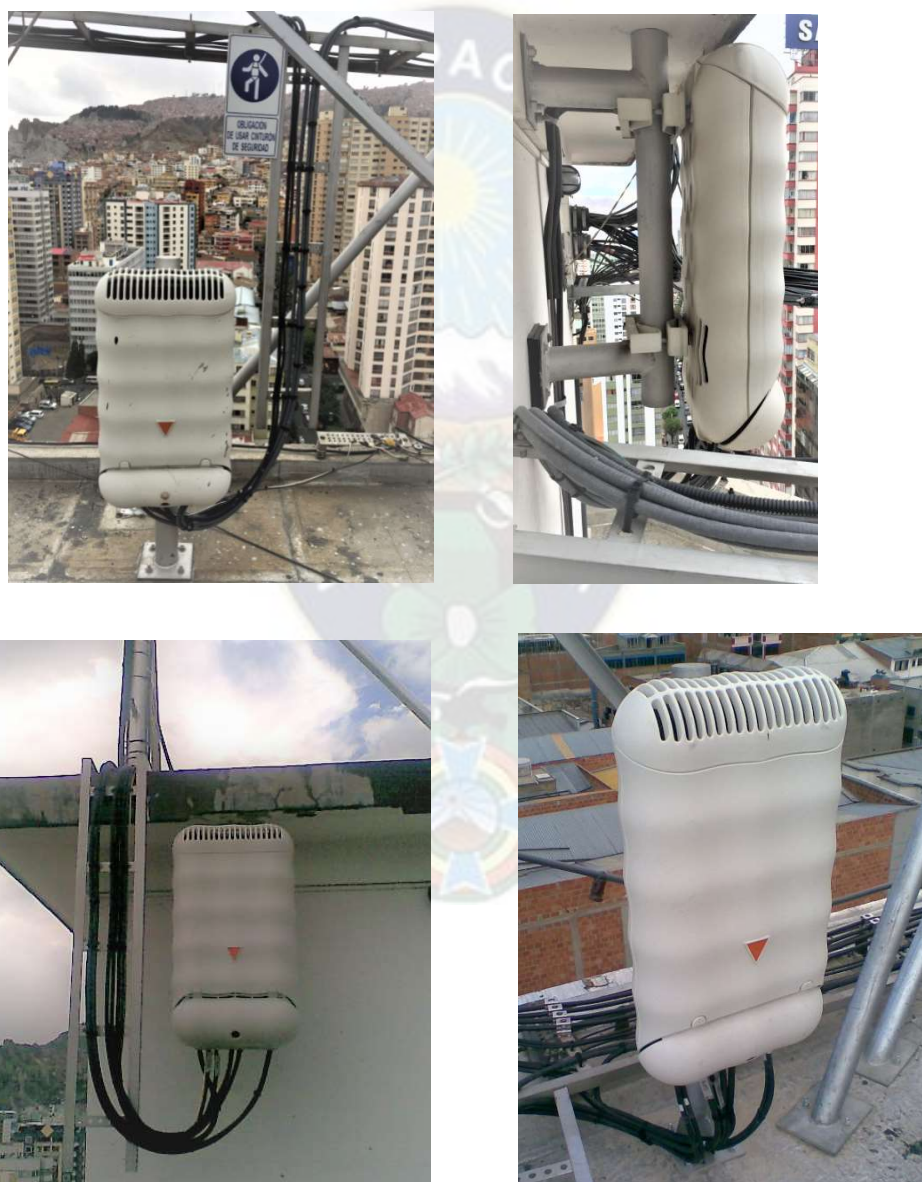
Figura 2-21: Montaje de las Radiobases WiMAX
