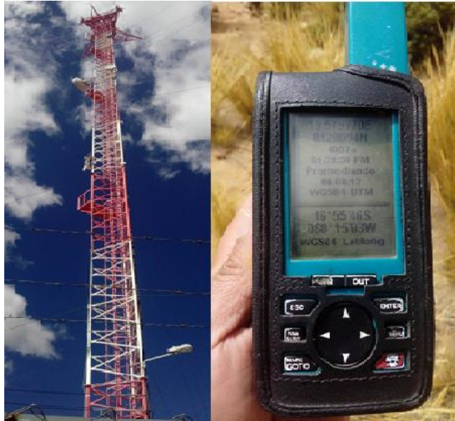
Figura 41: Torre Colquencha y su respectivos datos del GPS (Torre-Arriostrada) Fuente: Elaboración Propia
