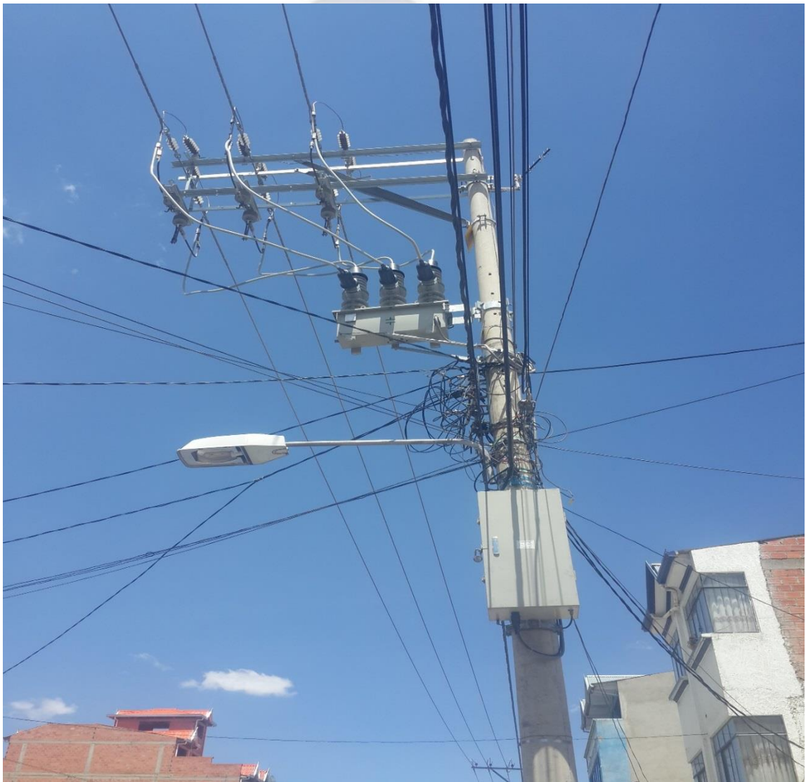
Fig. (2.4) Banco de Capacitores instalado sobre poste, ciudad de EL Alto-La Paz.
