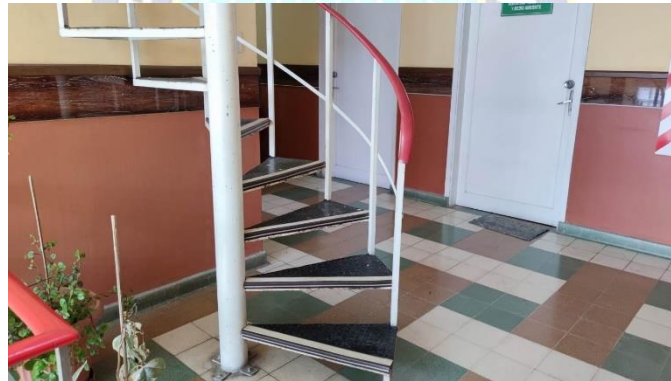
Ilustración 19: Armazón de escaleras Fuente: Propio
