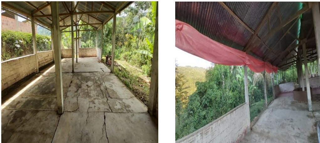
Figura 6. Instalaciones del galpón.
