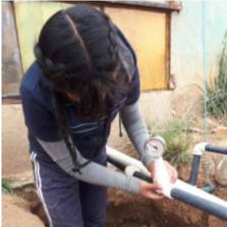
Figura 4. Medición de la presión de la bomba
