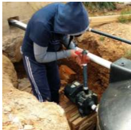
Figura 3. Instalación de la electrobomba
