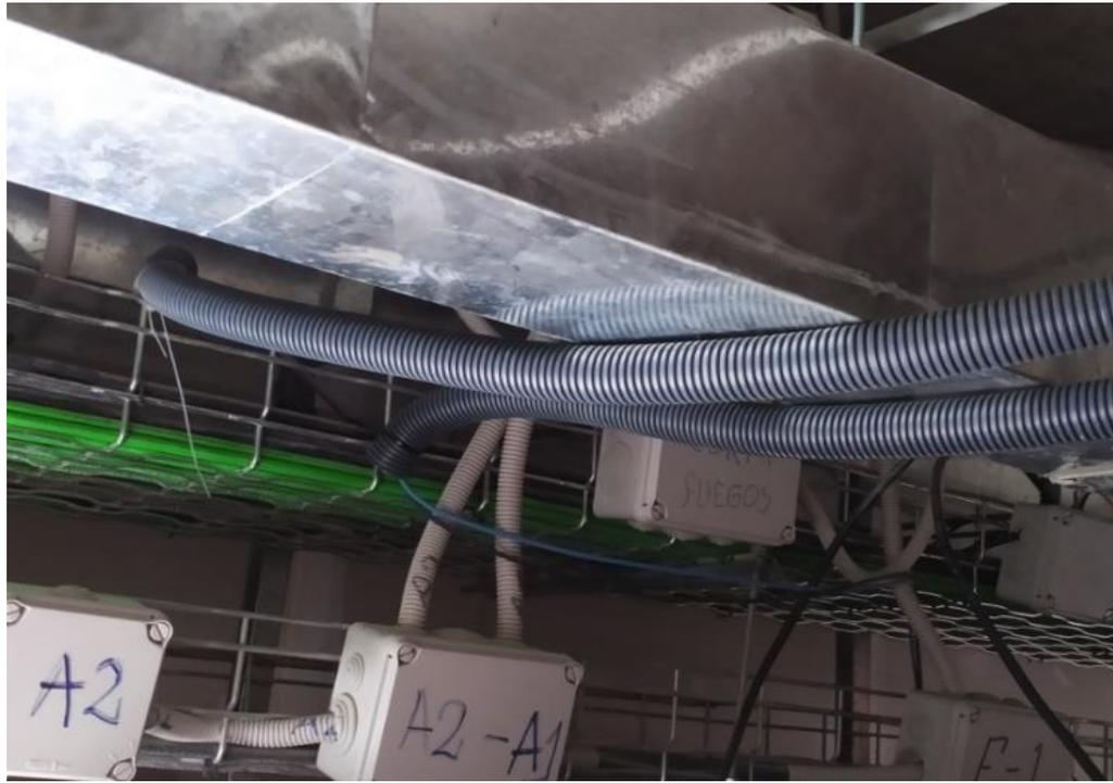
**Fotografía 25.** Visualización de cajas de conexión Eléctrica (AC)
