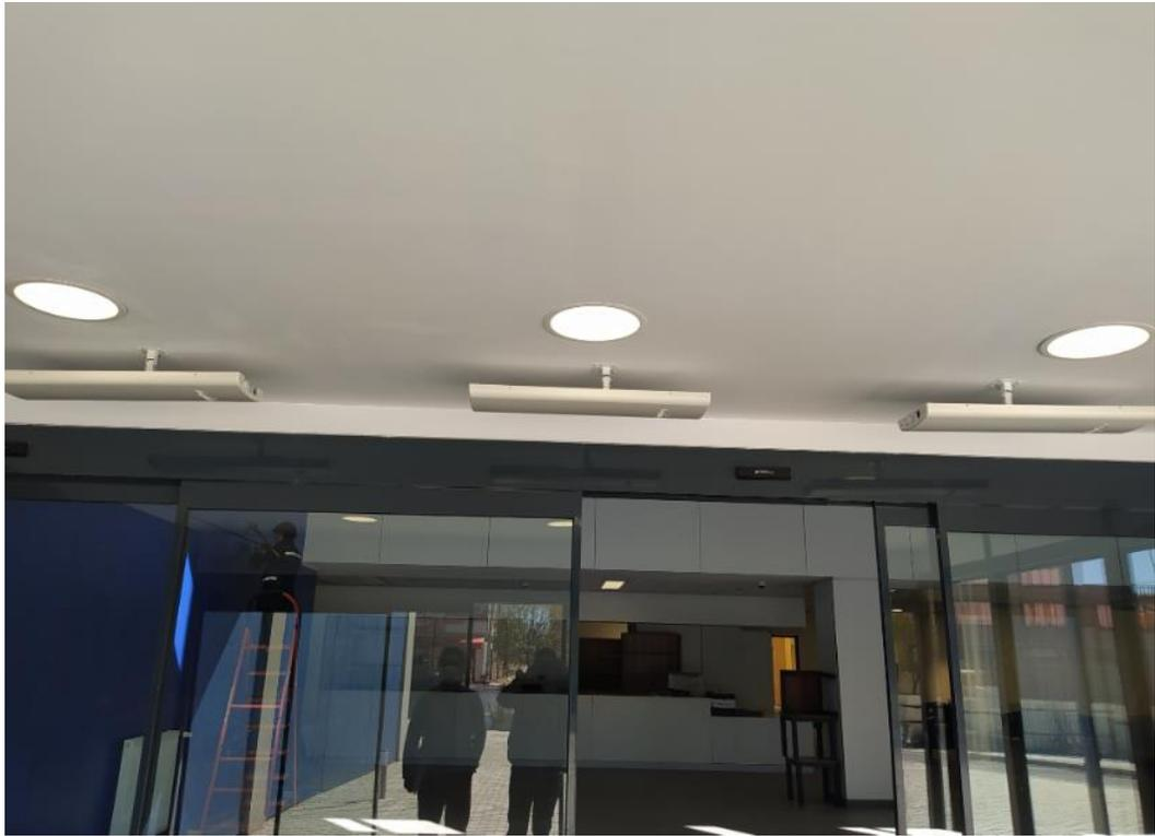
**Fotografía 7.** Visualización de las Antenas de RF
