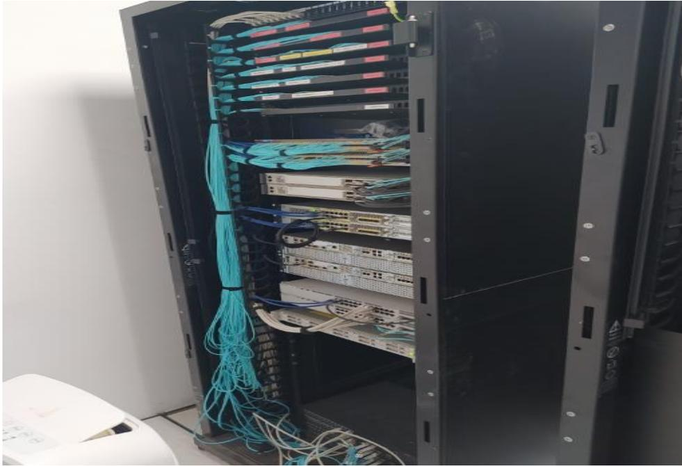
**Fotografía 3.** Visualización rack de ups switches routers
