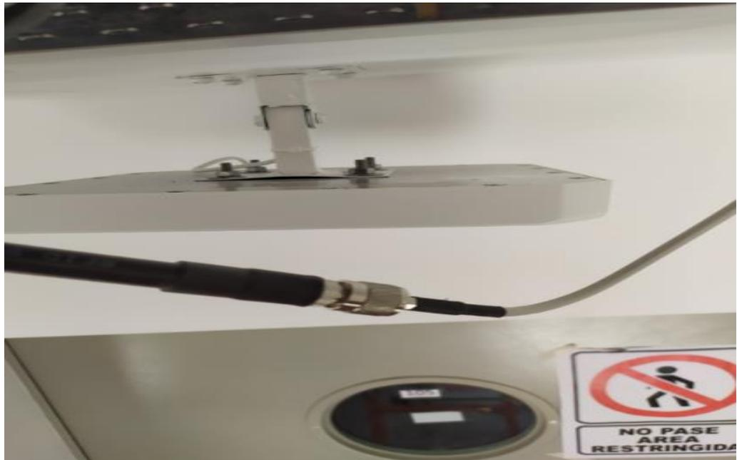
**Fotografía 23.** Visualización conectores SMA conectados
