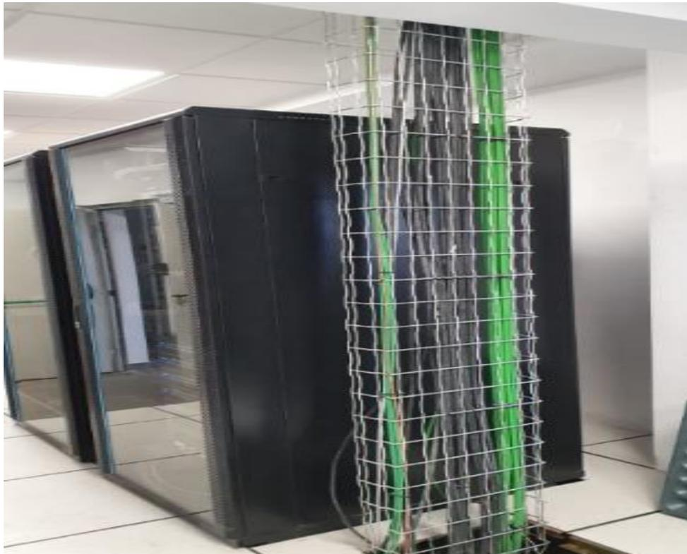
**Fotografía 15.** Visualización de rejillas donde pasa los cables UTP o de AC
