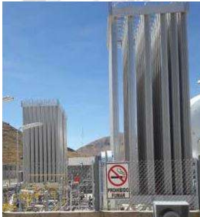
FIGURA 4.14 EVAPORIZADORES
