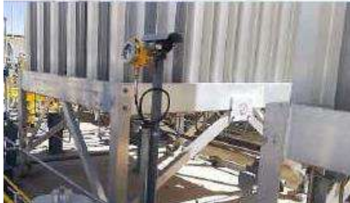
FIGURA 4.16 EVAPORIZADORES
