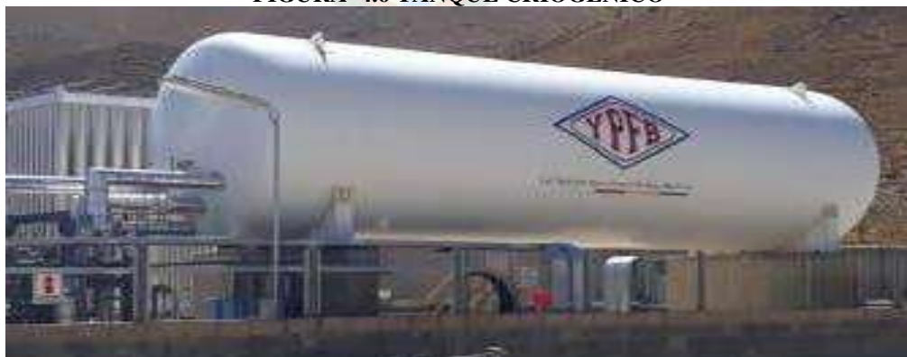
FIGURA 4.6 TANQUE CRIOGÉNICO
