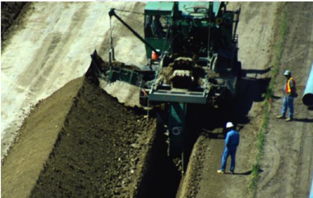
Figura 2.18: Apertura de la Zanja
