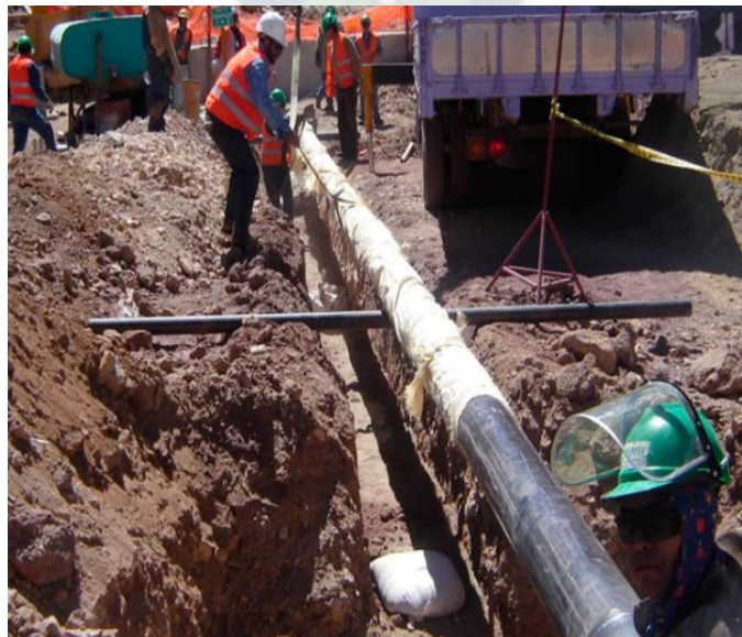
Figura 2.15: Construcción de Ductos
