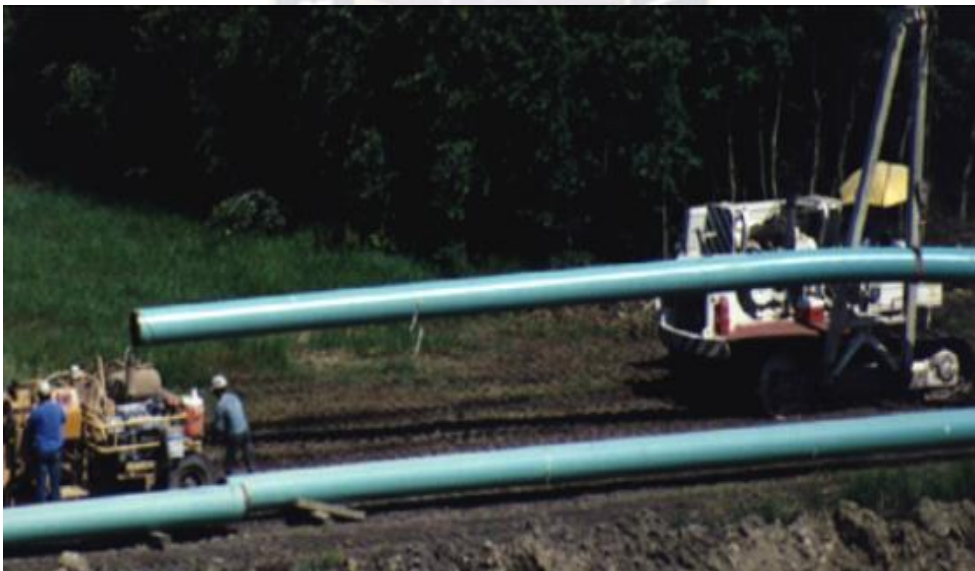
Figura 2.16: Tendido de Tuberías
