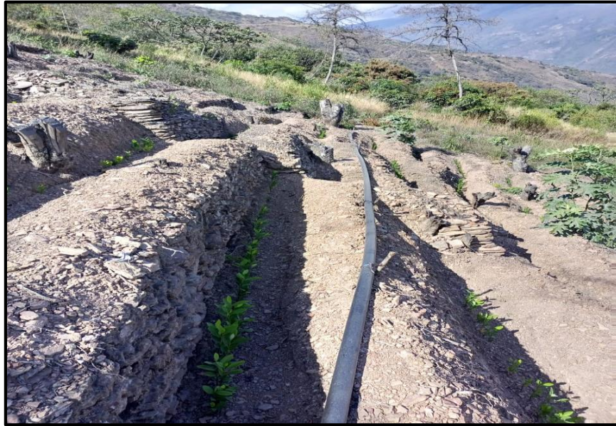
Figura A 1: Tendido De Tuberías (Actual) Fuente: Elaboración Propia
