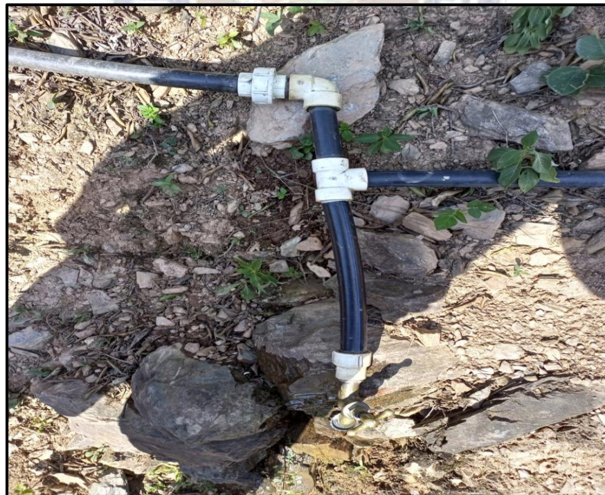
Figura A 2: Conexiones Provisionales Fuente: Elaboración Propia
