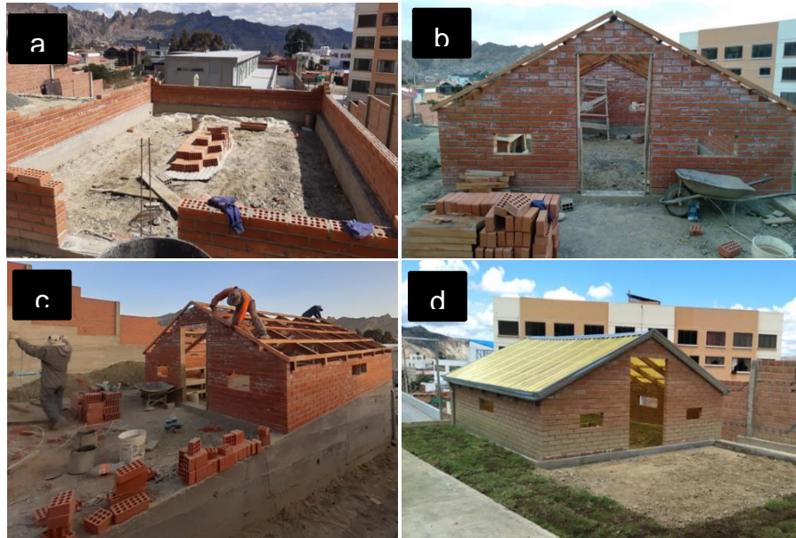
Fotografía 3. Proceso de construcción de un invernadero modelo para la producción local de hortalizas, granos y legumbres: a) Levantamiento de sobrecimiento, b) Vista frontal de ingreso, c) Techado y d) Invernadero concluido
