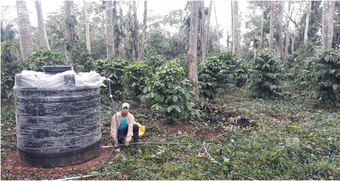
Instalación del sistema de riego por borboleamiento.
