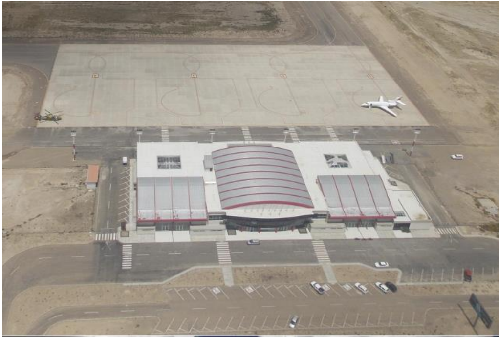
Figura 11 Estado actual de la señalización de plataforma
