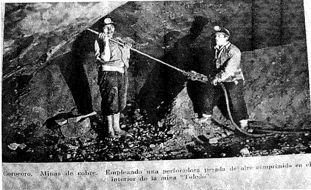
(Fotografía 2): Utilización de aire comprimido en la Mina Toledo en 1912
