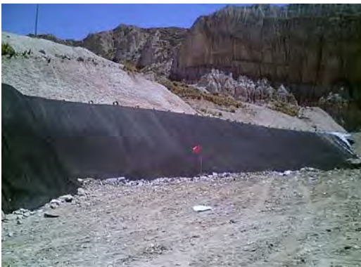
Vista Impermeabilización del Relleno
