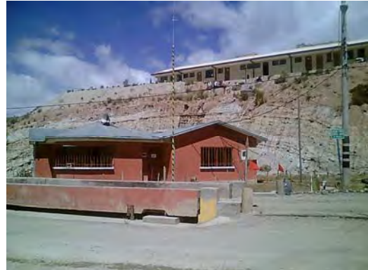
Ingreso Relleno Sanitario
