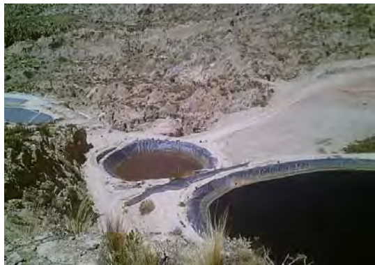
Planta de tratamiento de Lixiviados
