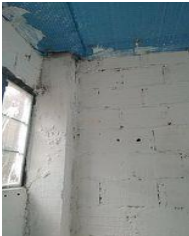
Figura 2. Limpieza y desinfección general del galpon de aves
