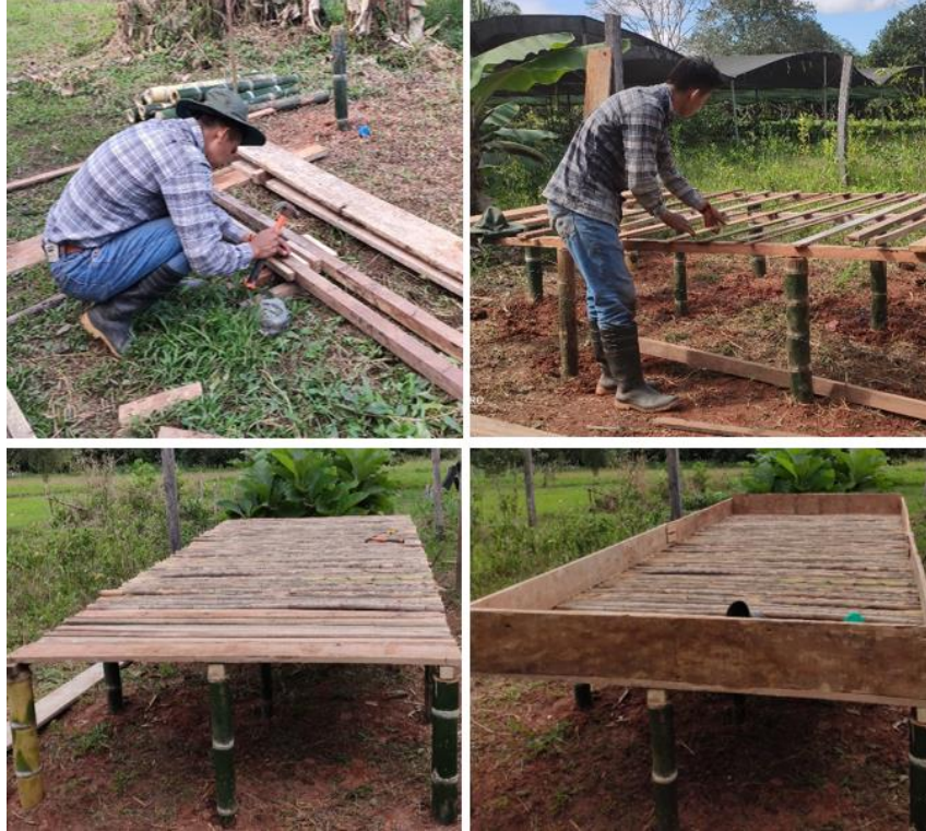
Construcción de la almaciguera
