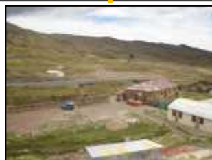
Imagen 40.-VISTA DE TOPOGRAFIA DEL TERREN Fuente: Imagen Propia (03 de Marzo 2019)
