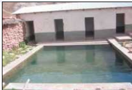
Imagen 32.-Piscina improvisada - Actual Balneario De Aguas Calientes Fuente: Imagen Propia (03 de marzo 2020)
