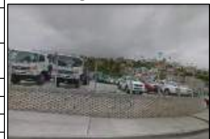
Ilustración 66: Terreno de intervención Fuente: Imagen propia
